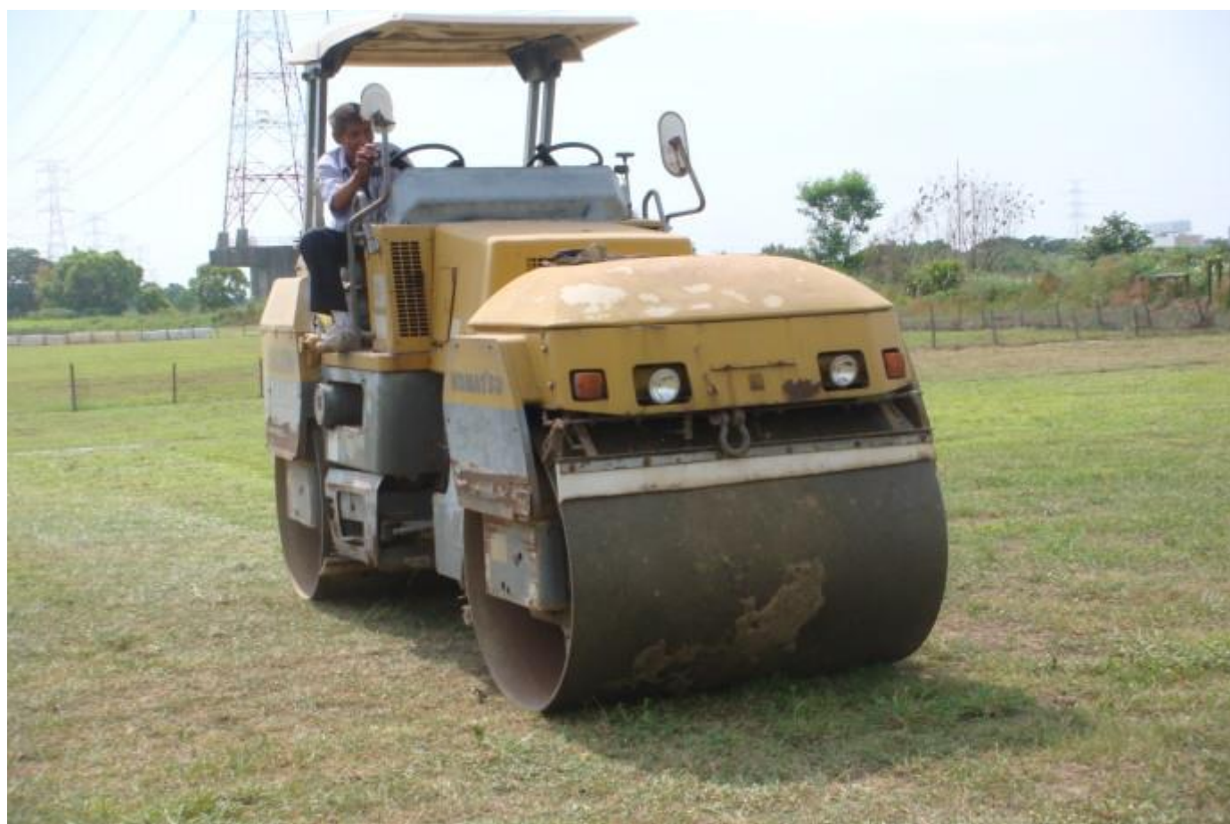
27、雇用壓路機壓平場地
